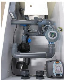
Composé d'une cellule, d'un coffret spécial électrolyseur.
