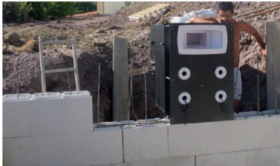
**1** Colocación sobre losa de hormigón o sobre una o varias filas de bloques
