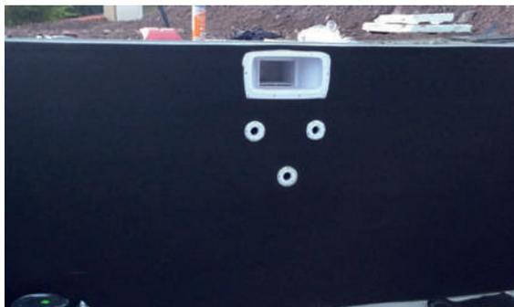
**5** Colocación del fieltro / revestimiento / PVC armado
