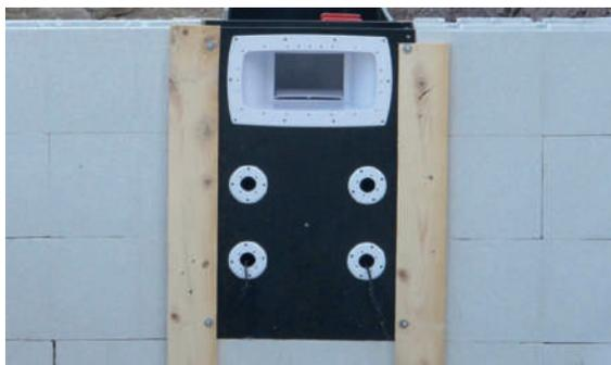
**3** Colocación de los encofrados delantero y trasero
