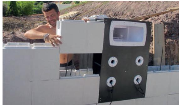
**2** Montaje de la estructura a ambos lados del muro filtrante
