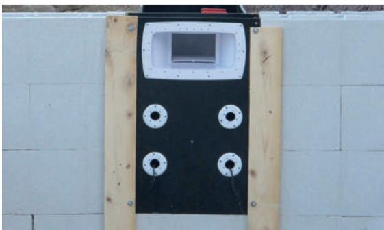
**3** Mise en place des coffrages avant et arrière
