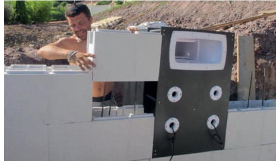
**2** Montage de la structure de part et d'autre du mur filtrant
