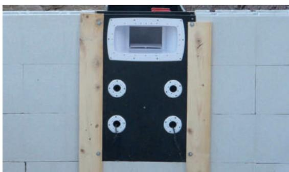
**3** Realizzazione delle casseforme su ogni lato del muro filtrante (davanti e dietro)
