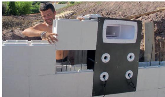
**2** Montaggio della struttura su entrambi i lati del muro filtrante
